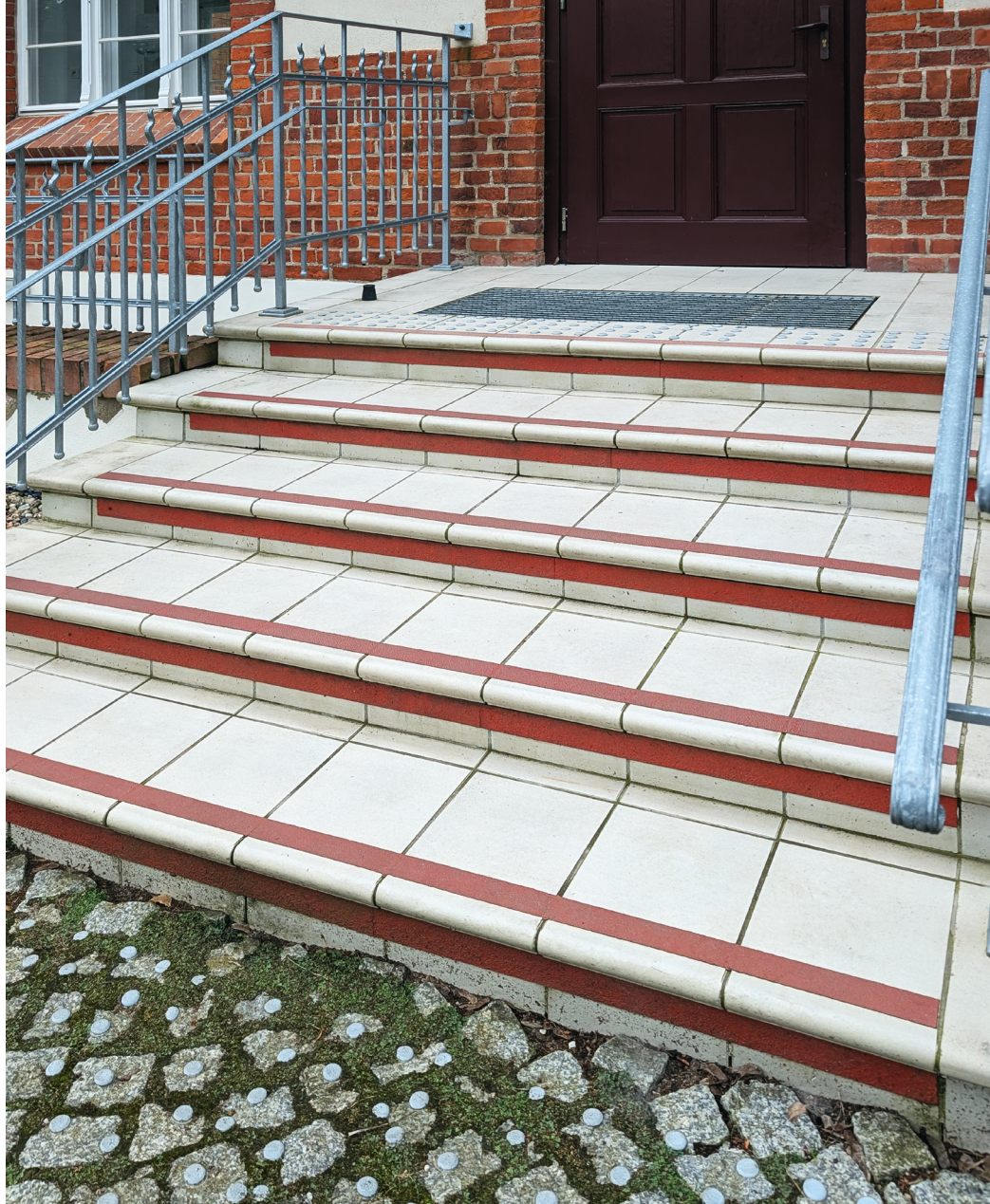
ZDJĘCIE 12. Pole uwagi – wypukłe punkty naklejone na kostkę brukową przed schodami. Szare kropki na szarej kostce. Widzicie? Na checkliście wniosku grantowego to zostało odhaczone. Czy spełniają one swoją funkcję? Nad tym nikt się nie zastanawiał. Fot. M. Storozenko-Polak
