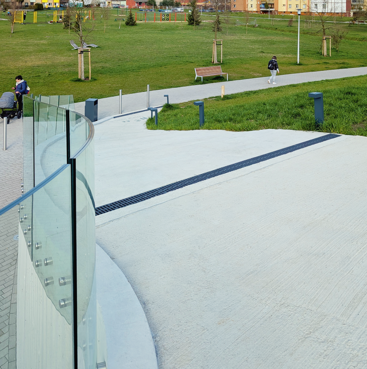
ZDJĘCIA 13 I 14. Kładka Wodnego Placu Zabaw w parku Jaworek w Tychach. Kładka o dużym nachyleniu (momentami ok. 19 stopni – ponad 30%). Na taką kładkę Magdalena Truchan nie wjedzie. Ciekawe, dlaczego projekt został nominowany w 2025 roku do nagrody Lider Dostępności. Fot. M. Storożenko-Polak
